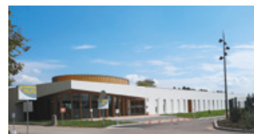
Bâtiment d'accueil du Centre psychothérapique de l'Ain
